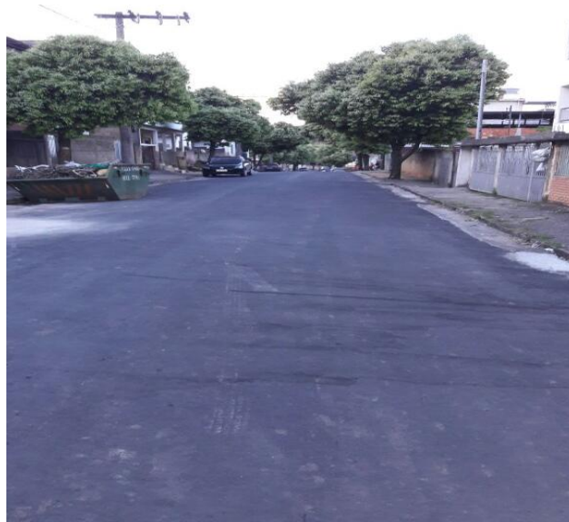
Escoamento de água pluvial no Bairro Carijós.
